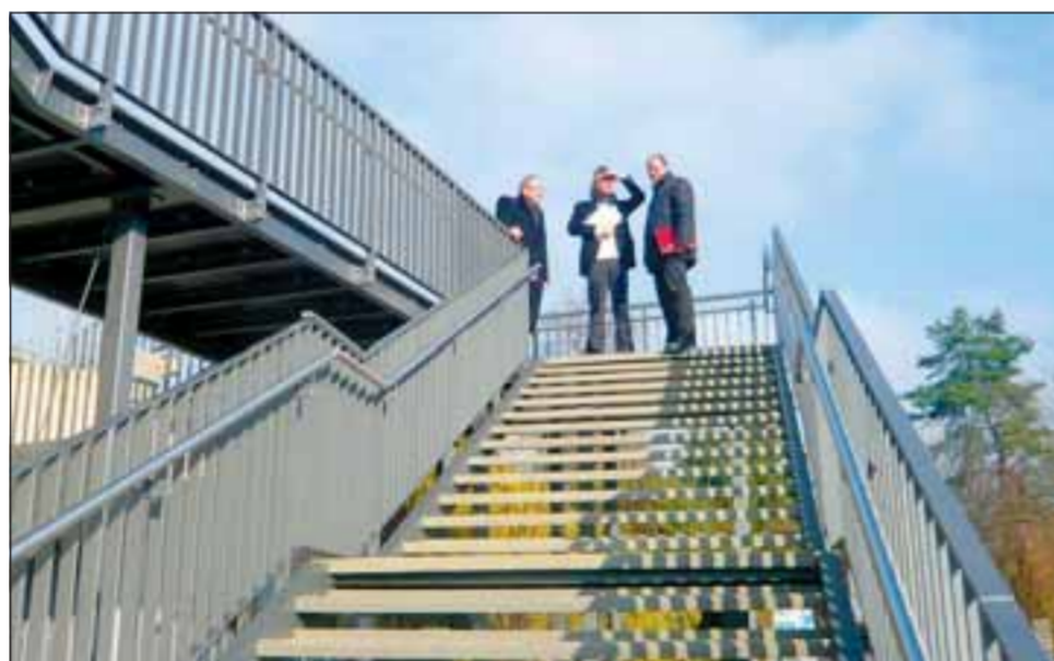
Tiefbauamtschef Karl-Heinz Bernhardt, Landschaftsarchitekt Michael Palm und Peter Zschippig von der städtischen Hochbauabteilung (v. li.) inspizierten gestern die Treppe. Foto: zg
